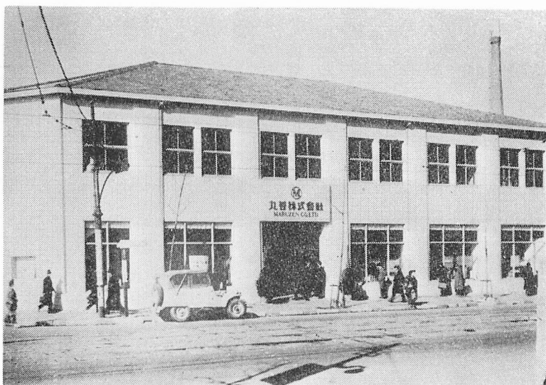
木造二階建日本橋本店（昭和22年12月竣工）
